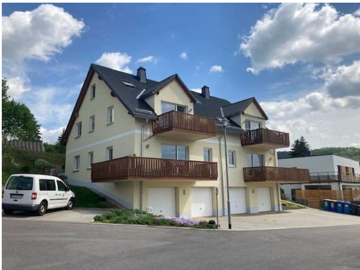
4-Familienwohnhaus Sonnenleithe Nr. 4 – vergleichbares Gebäude – Foto vom 13.05.2022 Insofern das Kellergeschoss (Garagen) im Mittel nicht mehr als 1,40 m über die Geländeoberfläche hinausragt, stellt dieses kein Vollgeschoss nach § 90 Abs. 2 SächsBO dar.
