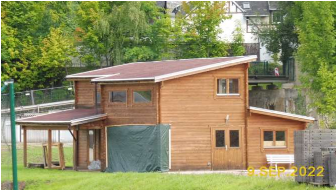
Foto bestehendes Mehrzweckgebäude, Ansicht von Süd-West, vom 09.09.2022
