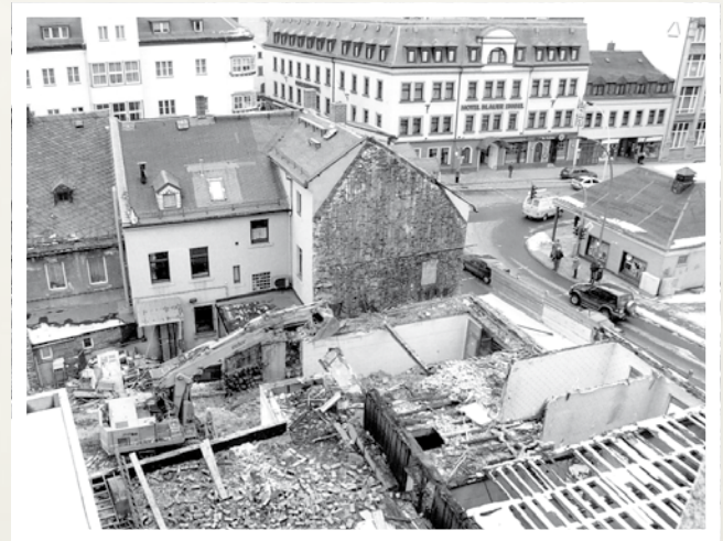
Baustelle Sparkasse und Apotheke von oben
