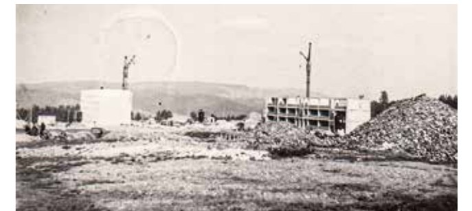
Der Gasthof Brünlasberg wurde zu Beginn abgerissen
