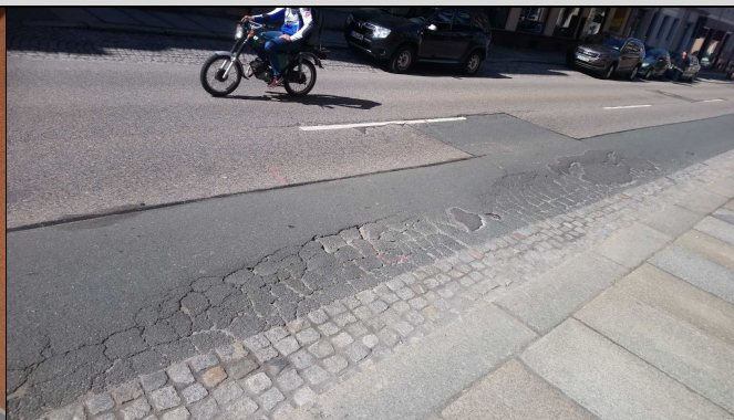
Straßeneinbrüche und Fahrbahnnunstetigkeiten im Bereich der östlichen Fahrspur nördlich der Dr.-Külz-Straße
