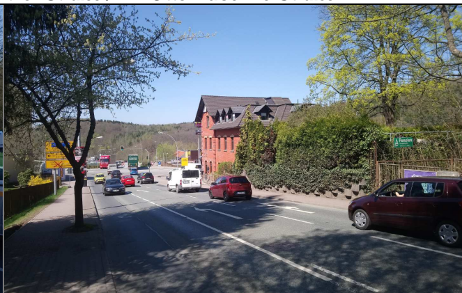
östliche Bebauung aus Richtung Süden (S 255)
