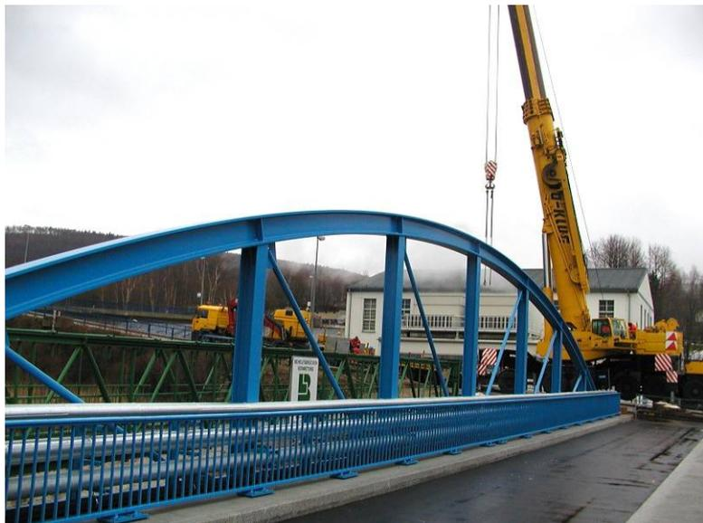
Brücke besitzt eine 3,5 m breite Fahrbahn sowie unterstromseitig einen 1,5m breiten Gehweg und dient außerdem als Medientrasse für Kabel und Leitungen. Die Baukosten betragen 604 000 €
