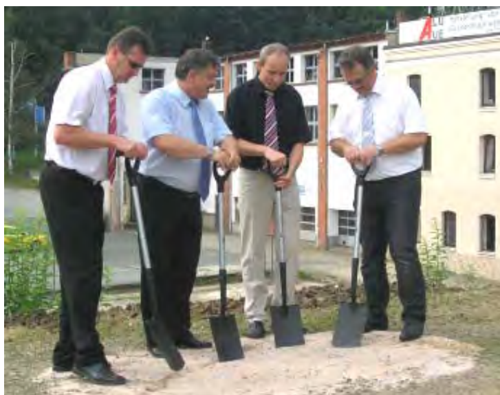
Erster gemeinsamer Spatenstich: Bürgermeister Kurbad Schlema Jens Müller, Oberbürgermeister Aue Heinrich Kohl, Bürgermeister Eibenstock Uwe Staab und Matthias Schiffner, Leiter der ARGE Aue- Schwarzenberg (v. l.).
