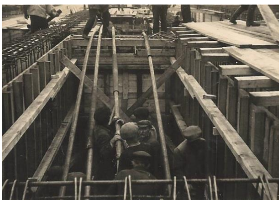
Abbildung 62 Einbau der Spannglieder mit Blechhülsenabschnitt im Querträgerbereich 18.09.1936
