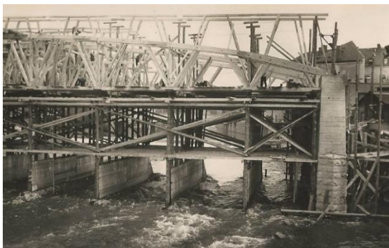
Abbildung 26 Lehrgerüst Pfeiler 3 am 29.07.1936
