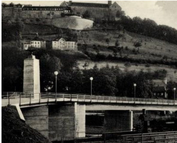
Abbildung 94 Pfeiler an einer Brücke in Kulmbach
