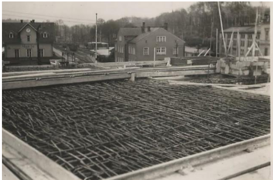
Abbildung 60 Bewehrung des Rückverankerungsblockes am Einhängeträger 30.10.1936 (Foto Herr Thömler)
