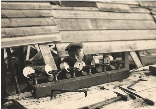
Abbildung 72 Manometer werden angebracht 21.12.1936
