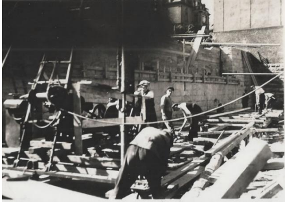
Abbildung 18 Rammarbeiten am Widerlager 0 am 17.09.1936 (Foto Herr Thömler)
