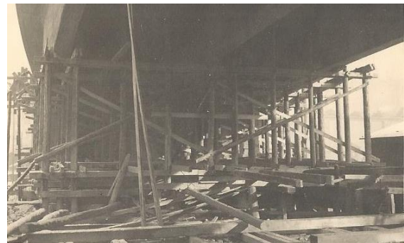
Abbildung 30 Lehrgerüst wird entfernt am 23.11.1936
