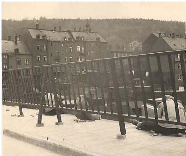
Abbildung 85 Ausmeißeln hinter dem Gitter, 05.05.1937
