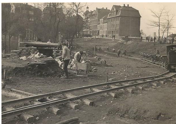
Abbildung 89 Anlegung der Zufahrtsstraße, 30.03.1937
