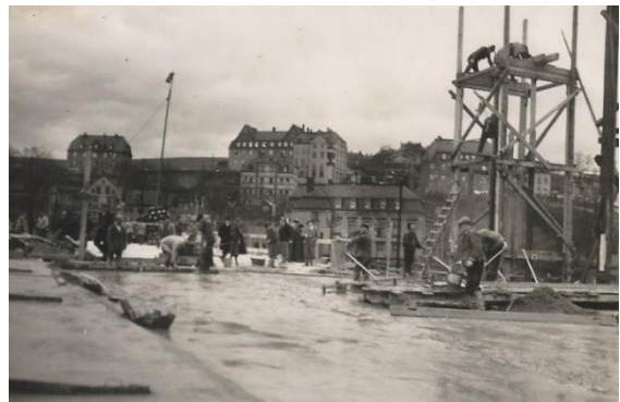
Abbildung 41 Die letzte Mischung für die Fahrbahnplatte Bauteil C am 13.11.1936
