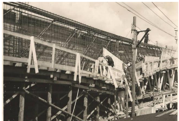
Abbildung 33 Armierung des rechten Randbalkens über Pfeiler 3 am 27.08.1936
