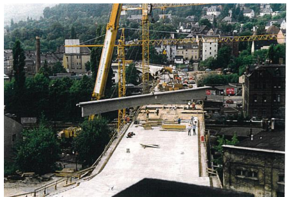
Abbildung 126 Montage der Fertigteile des Einhängerträgers 14.07.1995
