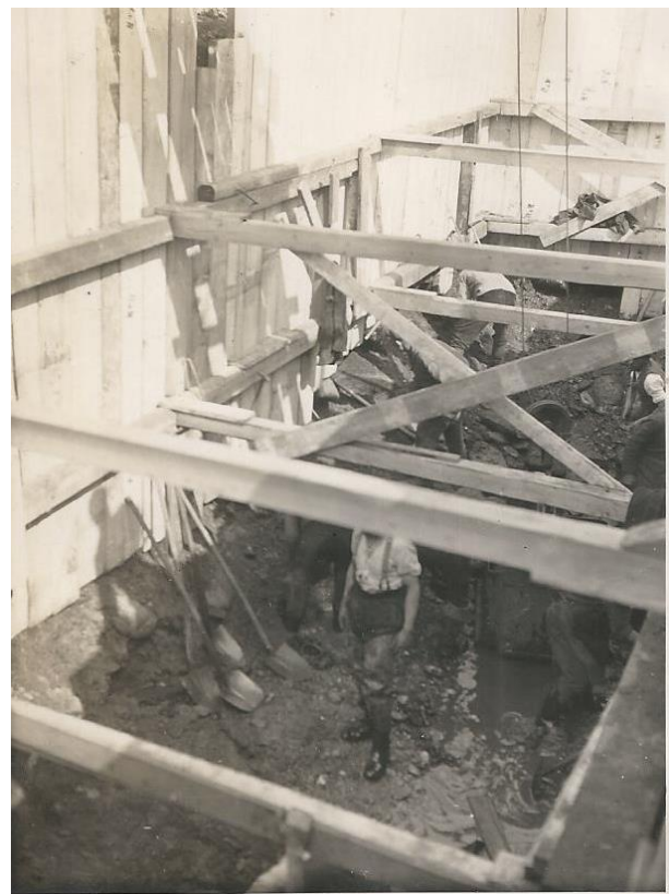
Abbildung 17 Baugrube des Pfeilers 5 am 14.05.1936
