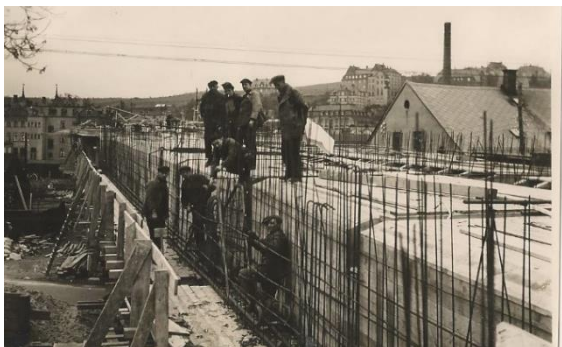
Abbildung 38 Armierung des linken Randträgers, Bauteil A am 9.10.1936
