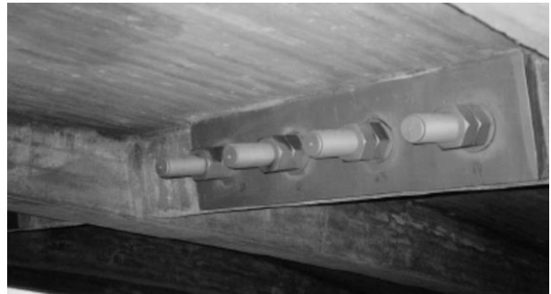
Abbildung 79 Replik Verankerungsplatte [8, S.337 Bild15]
