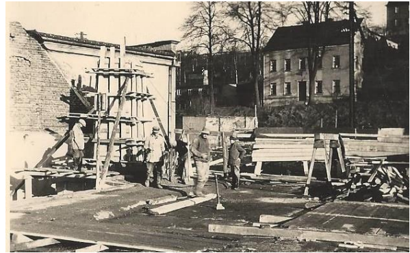
Abbildung 96 Gießen der Pylone, 11.12.1936
