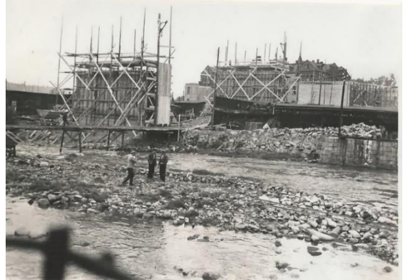
Abbildung 21 Schalgerüst von Pfeiler 5 und 6
