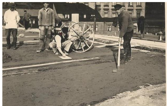
Abbildung 42 Ebnet des Betons am 22.04.1937
