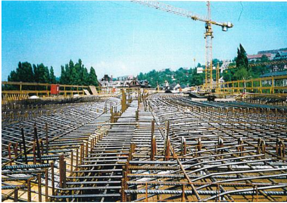
Abbildung 121 Armierung Druckplatte Stahlbetonteil Mai 1994
