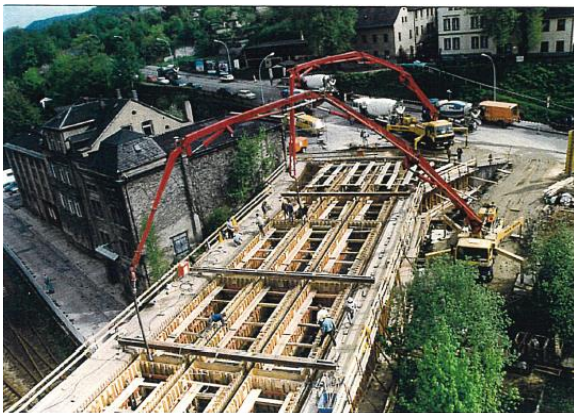
Abbildung 123 Betongang Kragträger Achse 9 und 10 am 11.05.1995
