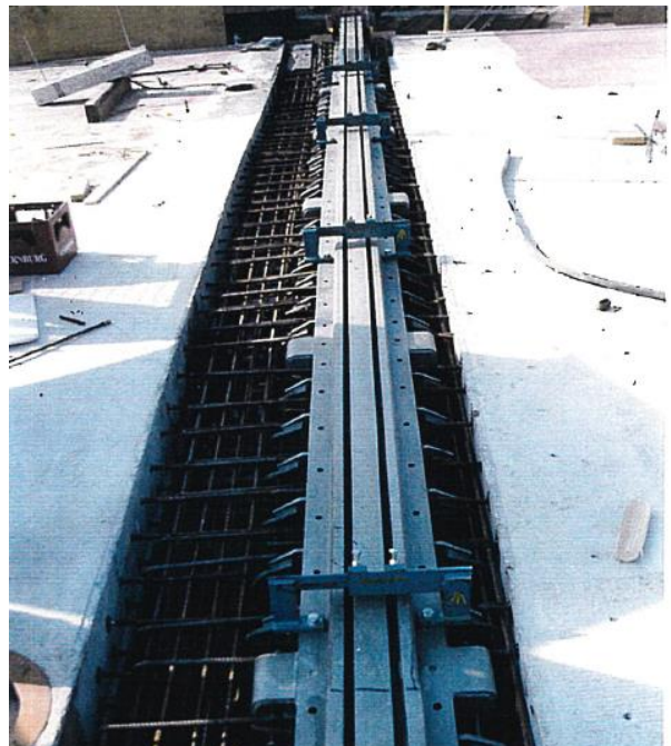
Abbildung 131 Übergangskonstruktion Achse 9 Seite Lößnitzer Straße, 25.08.1995
