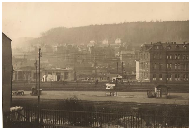
Abbildung 10 Abbruch des Viktoria-Hotels 27.04.1936 (Foto Herr Thömler)
