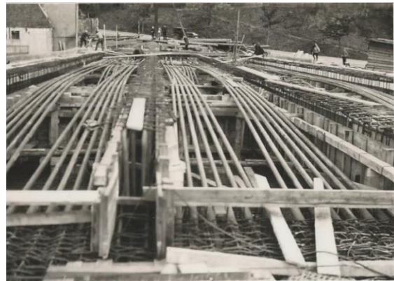
Abbildung 64 Spannglieder im rechten Kragträger 09.10.1936
