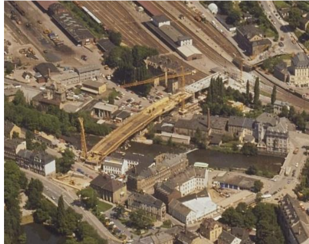
Abbildung 113 Luftbildaufnahme der Baustelle
