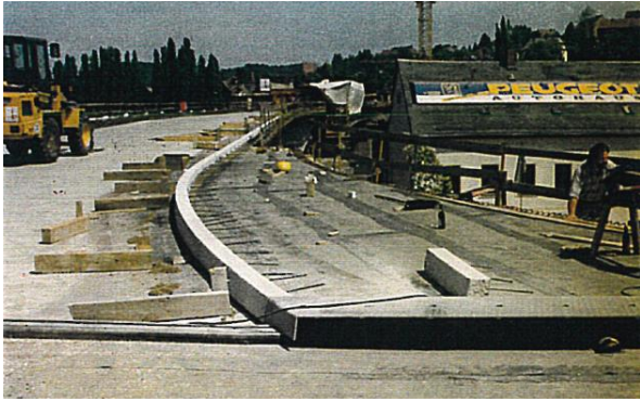
Abbildung 127 Verlegung der Granitborde Juni 1995
