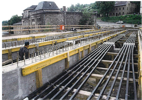
Abbildung 124 Spanngliedgruppe A Kragträger Achse 9 und 10 Mai 1995
