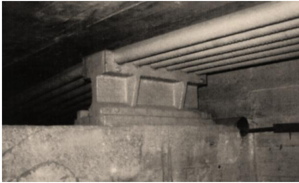
Abbildung 67 Eingebautes Pendellager
