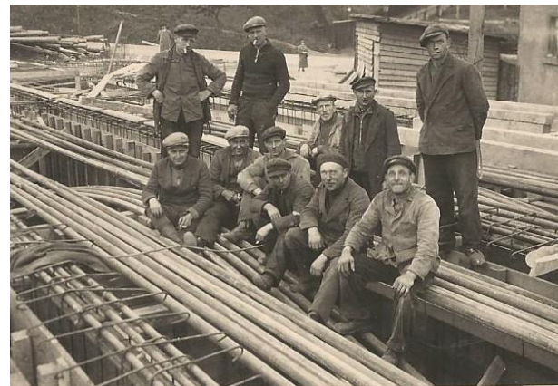
Abbildung 71 Die „Berliner Jungen“. Facharbeiter für die Armierung von Stahlbetonbauten
