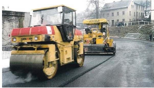
Abbildung 130 Aufbringen der Splittmastix-Decke auf einer Schutzschicht aus Gussasphalt Dezember 1995
