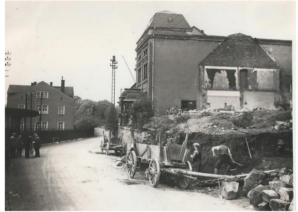
Abbildung 16 Mauerabbruch bei Pfeiler 10
