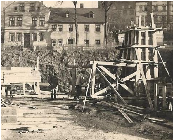
Abbildung 95 Gießen der Pylone, 11.12.1936, Anschluss Lößnitzer Straße
