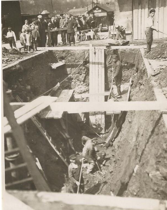
Abbildung 14 Baugrube des Pfeiler 7 am 5.06.1936
