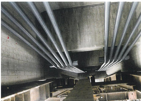
Abbildung 54 Umlenkstellen der externen Vorspannbewehrung am Einhängeträger (Bild stammt vom Neubau August 1995)
