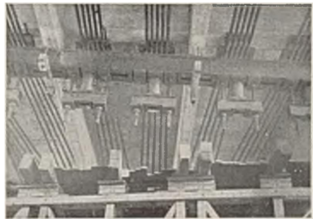
Abbildung 55 Pressen an den Ablenkungspunkten des Einhängeträgers [2, S. 103 Abb. 24]
