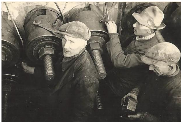
Abbildung 75 Anspannen der Spannglieder 22.12.1936
