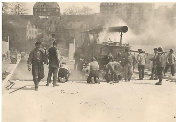
Abbildung 84 Asphalt wird aufgebracht 07.05.1937 (eine der schweißtreibendsten Arbeiten auf einer Baustelle)
