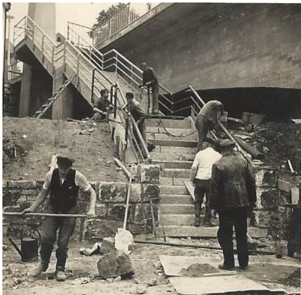
Abbildung 88 Fertigstellung der Treppe zur ehem. Alberodaer Straße, 04.06.1937
