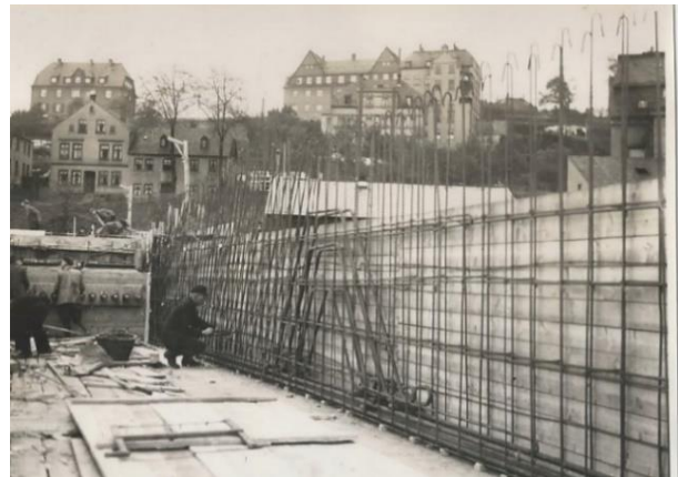
Abbildung 58 Bewehrung des Einhängeträgers (Randträger) 19.10.1936
