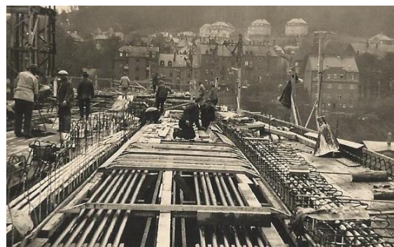
Abbildung 66 Schalarbeiten oberhalb der Spannglieder (Foto Herr Fischer)
