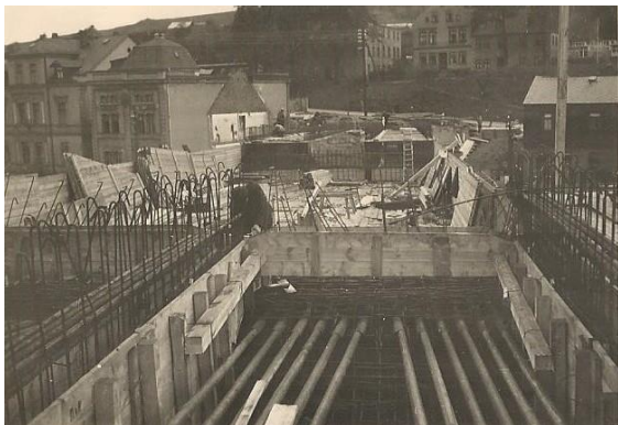
Abbildung 61 Eingezogene Spannglieder mit Hüllrohren in den Durchdringungsbereichen
