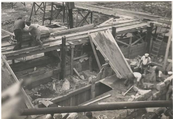
Abbildung 15 Maurerarbeiten am Pfeiler 3 am 23.06.1936 (Foto Herr Thömler)
