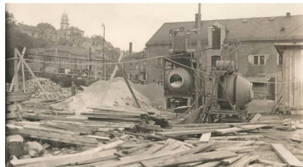
Abbildung 31 Die beiden Mischanlagen von Pfeiler 7 und 8 am 14.05.1936 (Foto Herr Thömler)
