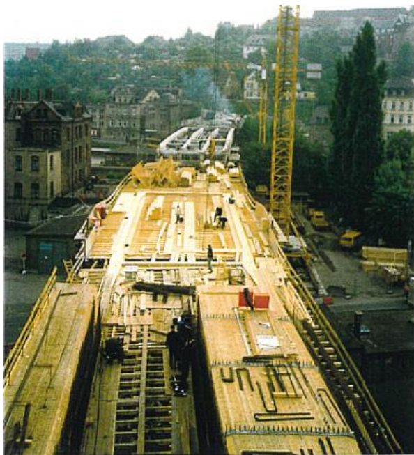
Abbildung 118 Schalung Stahlbetonteil Hintergrund Abbruch des alten Spannbetonabschnittes Juni 1994
