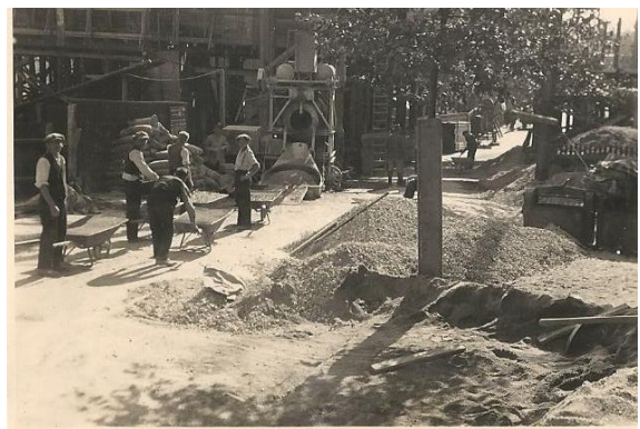
Abbildung 34 Arbeiten an der Mischmaschine, Niederschlemaer Weg am 17.09.1936
