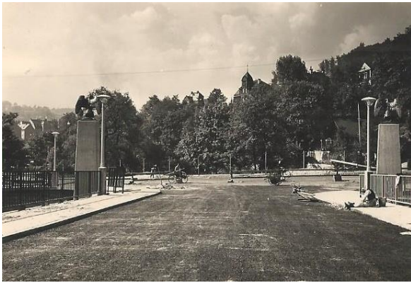
Abbildung 100 Pylone im Bereich der Einmündung in die Schneeberger Straße
