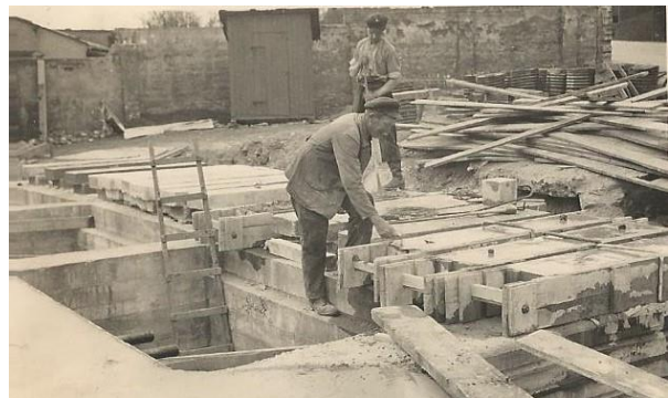
Abbildung 80 Guss der Abdeckplatten Verankerung Kragträger am 12.04.1937
