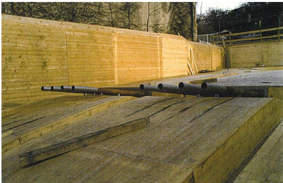
Abbildung 122 Schalboden und Hüllrohrbatterien Kragträger Achse 9/10
