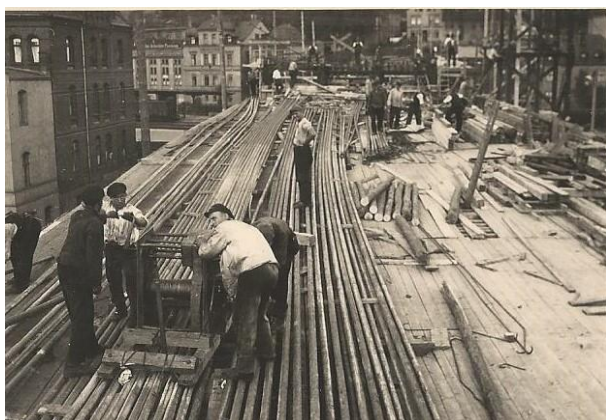
Abbildung 57 Einziehen der Spannlieder 26.09.1936
