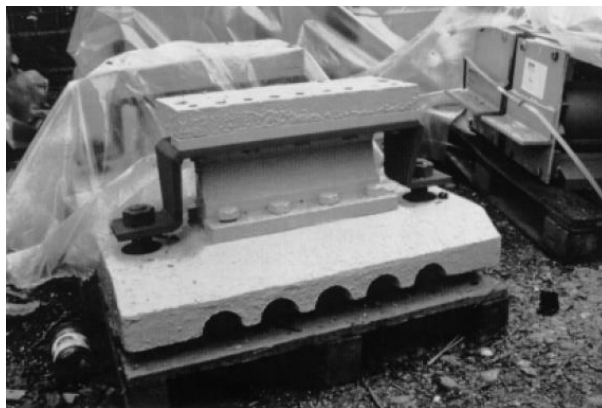
Abbildung 56 Zum Einbau bereitstehendes Pendellager Bild vom Bau 1997 [8, S.338 Bild 16]
