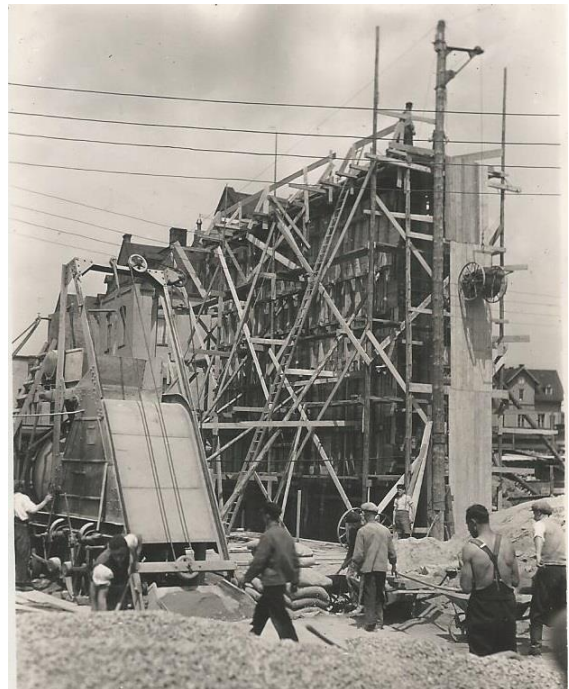
Abbildung 22 Betonieren von Pfeiler 8
