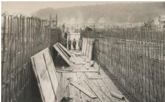
Abbildung 36 Einschalen des Einhängerträgers am 20.10.1936
