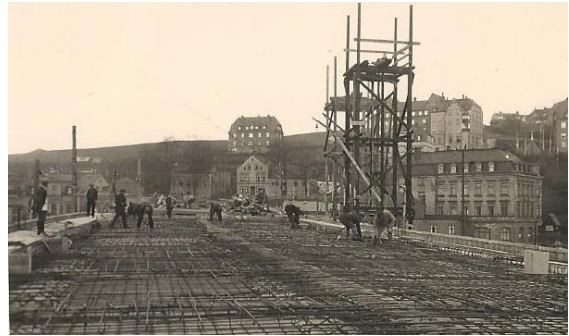
Abbildung 39 Armierung der Fahrbahndecke Teil C am 10.11.1936
