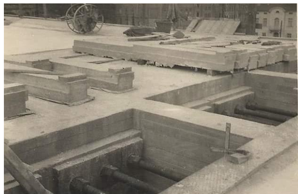
Abbildung 81 Ankerstellen eines Kragarmes zur Abdeckung vorbereitet
