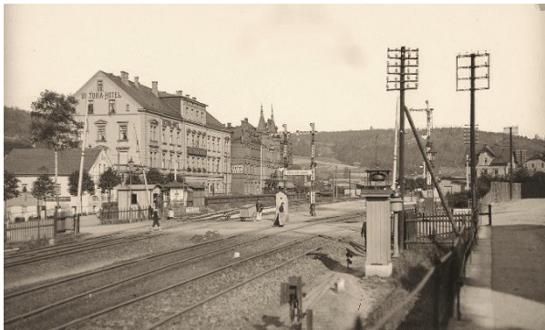
Abbildung 1 Schienengleicher Übergang mit dem Viktoria-Hotel
