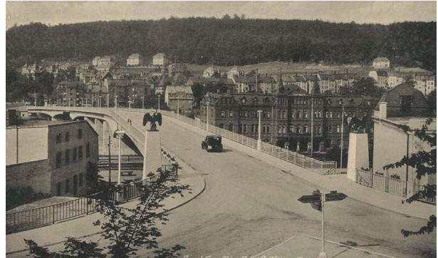
Abbildung 102 Brückenzufahrt Lößnitzer Straße nach Fertigstellung mit Fahrbahnsteiler
