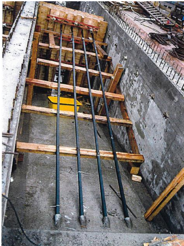
Abbildung 128 Spanngliedgruppe B Kragträger Achse 7/8 im noch ungedeckten Hohlkasten, März 1995
