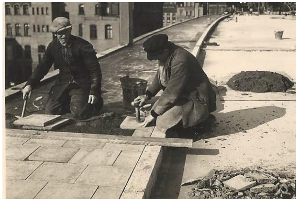
Abbildung 83 Plattenleger bei der Arbeit, 22.04.1937 (Brücke noch ohne Geländer!)
