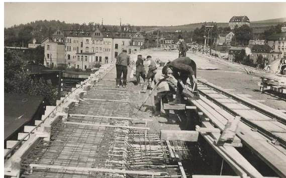
Abbildung 40 Betonieren der Fahrbahnplatte, Bauteil B am 17.09.1936
