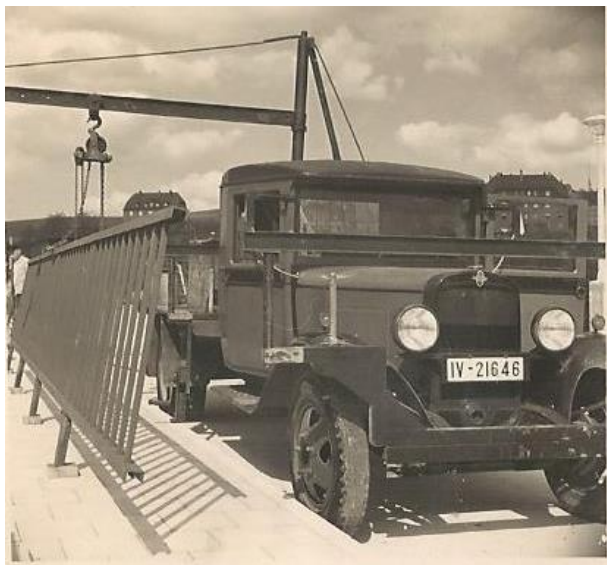
Abbildung 86 Einhängen des Geländers mittels eines Krans, 07.05.1937
