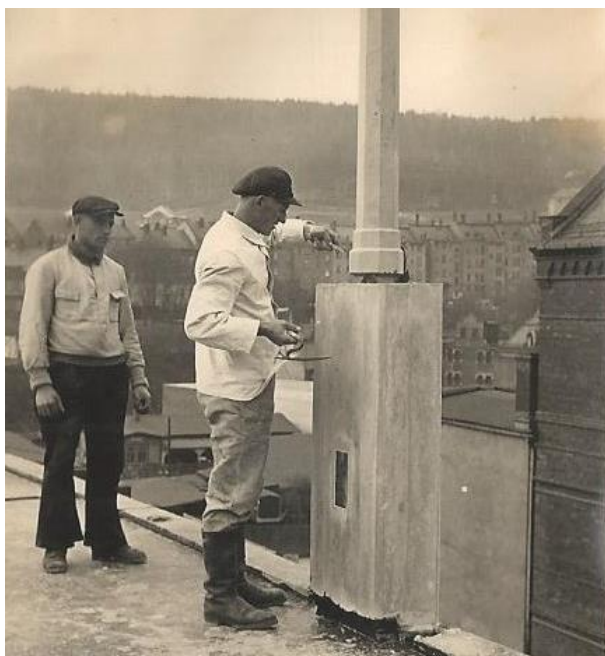
Abbildung 91 Anbringen eines Lichtmastes 29.04.1937
