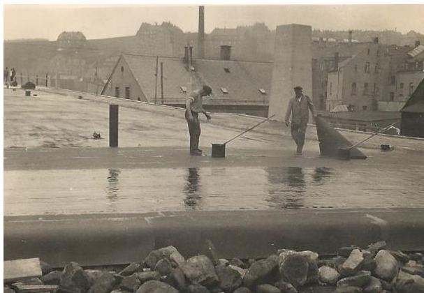
Abbildung 82 Auf Bauteil A wird die Fahrbahn geteert 09.04.1937
