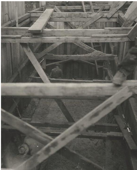
Abbildung 19 Betonage des Fundaments von Pfeiler 8
